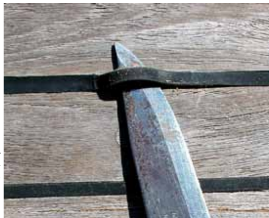
Till vänster om knivbladet, ser man ny nåt med synlig skarv till den gamla nåten som lossnat.
