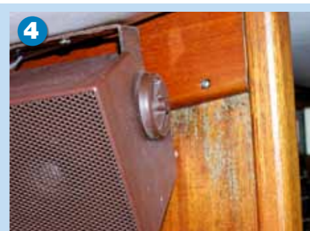
På andra sidan av skottet ser det nästan likadant ut och det är lite svart runt skruvsallen. Men då är det inget lackfel. Tittar du riktigt noga ser du att hållaren/bygeln till högtalaren rostas där den ligger an mot garneringen.
